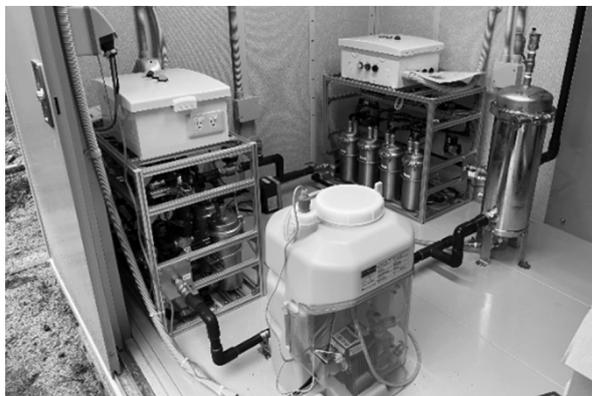
図4 某浄水施設の更新で小型膜ろ過装置（MBNシリーズ）を設置
