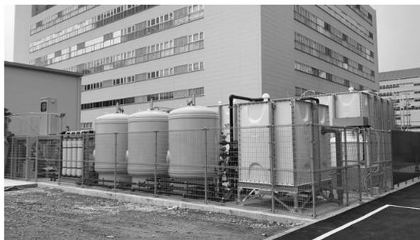
図1 地下水膜ろ過システム
