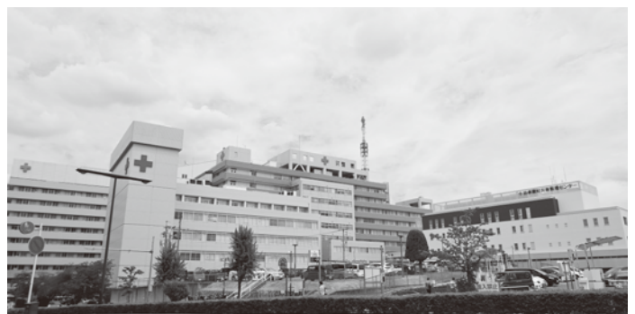
日赤名古屋第二病院の建物(左)と日赤愛知災害管理センター棟(名古屋市昭和区)
