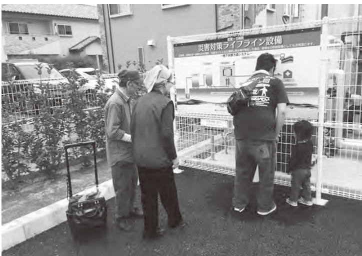
熊本市内の病院に設置された地下水膜ろ過システム。熊本地震では近隣住民に水を提供した
